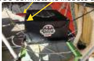
INSTALAÇÃO DOS CABOS DO VISOR E DO CONTROLE NO MÓDULO DE
